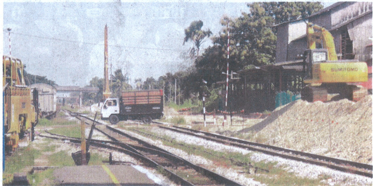
■ Kerja-kerja pembinaan landasan berkembar giat dijalankan.
